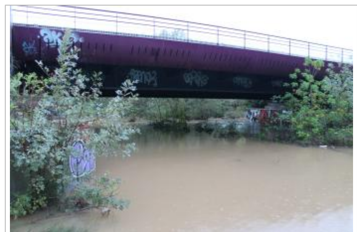
Sous le pont côté amont
