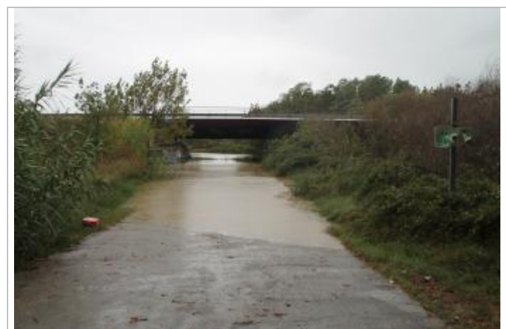
Pont vu depuis le chemin côté nord #2
