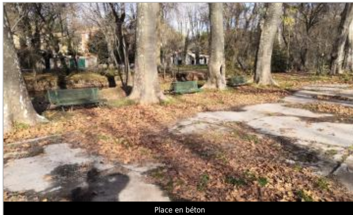
Place en béton
