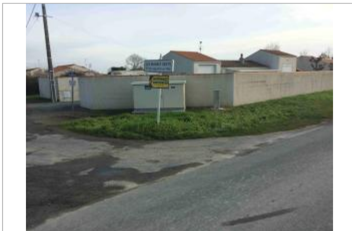
Point de vue du site
