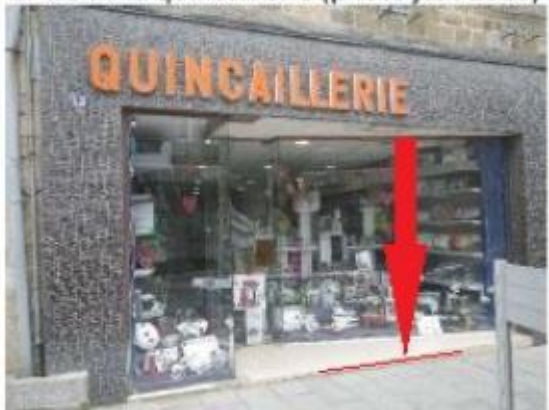
Laisse de crue au niveau de l'entrée du magasin.
