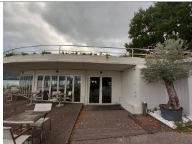
Entrée restaurant du Lido
