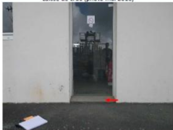
L'eau a atteint le haut de la première marche.
