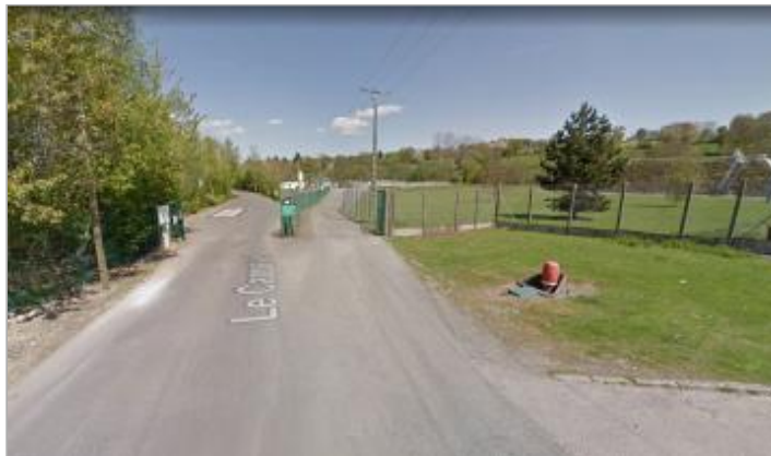
Marche de la porte d'entrée du bâtiment de la station d'épuration, Le caquevel.
