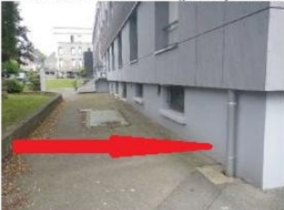
Altitude de la cote relevée sur le mur de la clinique rue Général De Gaulle par SCE en 2002.
