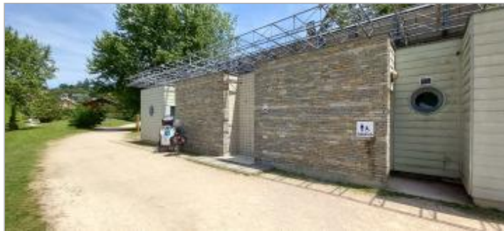
Bâtiment sanitaire proche de la plage aux Dames
