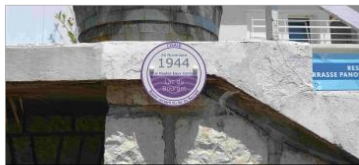
Repère de crue 26 novembre 1944
