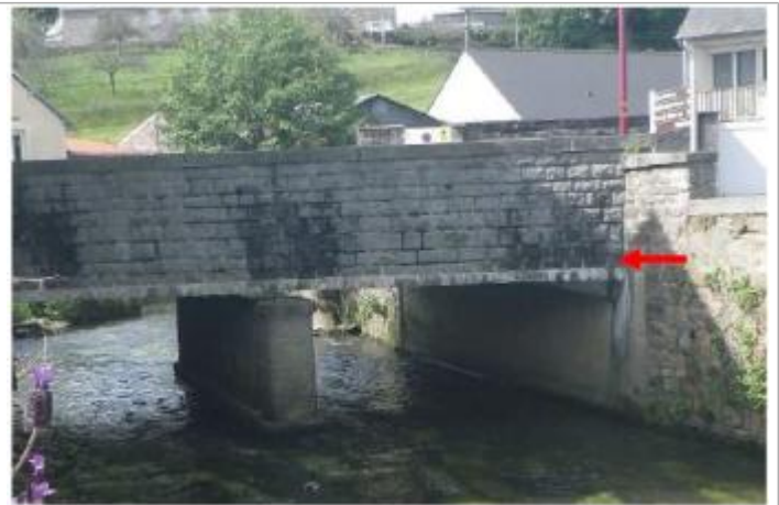
Parapet en pierres sur le pont de la rue Jean Casté.
