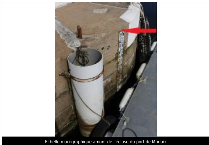
Echelle marégraphique amont de l'écluse du port de Morlaix
