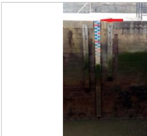
Echelle marégraphique aval de l'écluse du port de Morlaix
