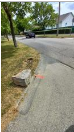
Laisse de crue au sol
