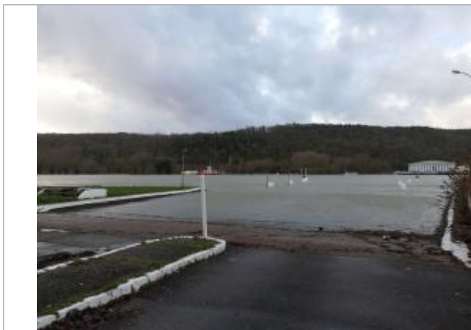
Sol bitumé de la mise à l'eau du Bac de Petit Couronne, Chemin du Pass d'Eau.
