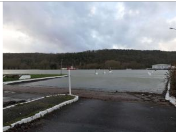
Sol bitumé de la mise à l'eau du Bac de Petit Couronne, Chemin du Pass d'Eau.
