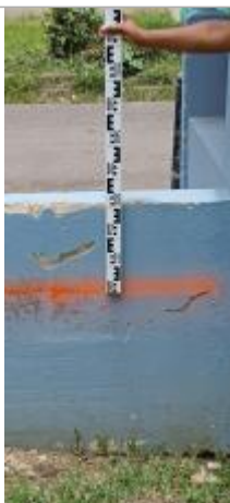
Niveau mesuré depuis le rebord de haut en bas
