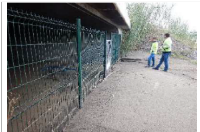
Vue du site
