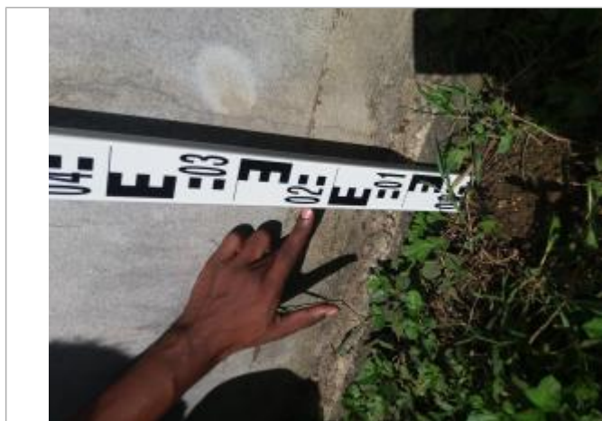
Dépôts de matières solides
