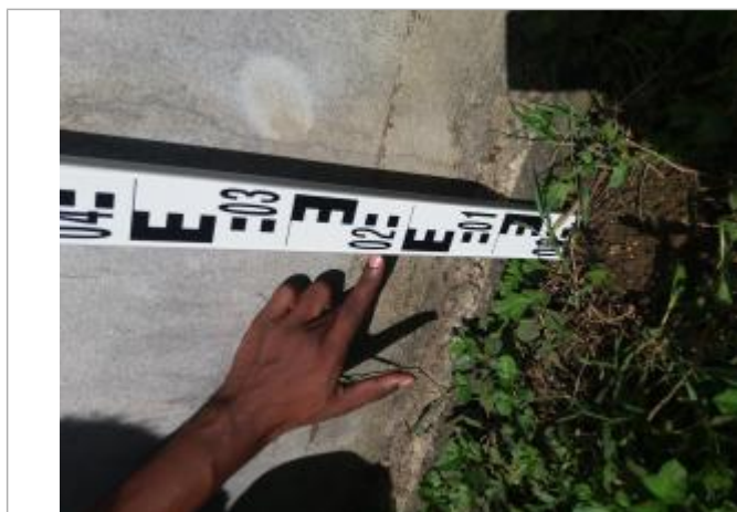
Dépôts de matières solides
