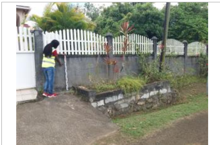
Mur de clôture
