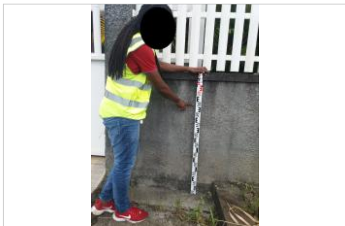
Dépôts de matières solides
