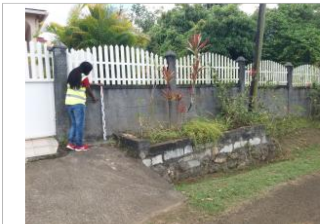
Mur de clôture
