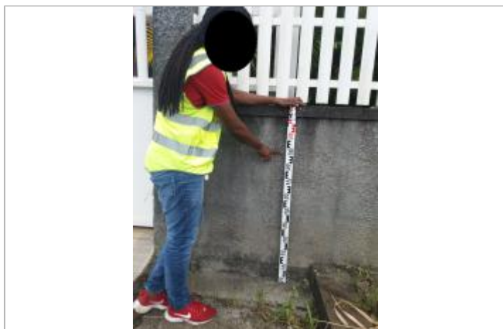
Dépôts de matières solides
