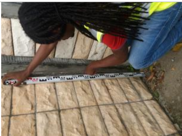
Dépôts de matières solides
