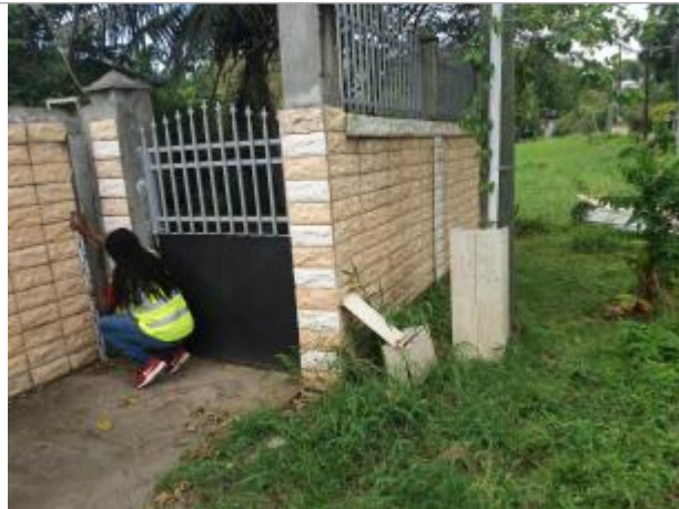
Mur de cloture à gauche du portillon d'entrée
