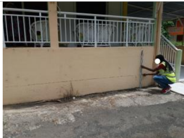
Route de chazeau au droit intersection route de pavé - Imp Reveillé
