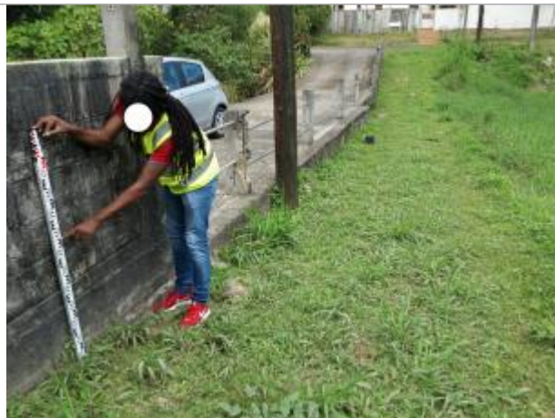
Route de chazeau au droit intersection route de pavé
