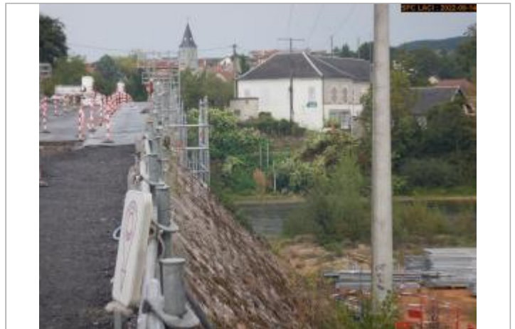
Vue du site éloignée
