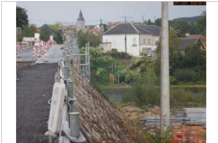
Vue du site éloignée
