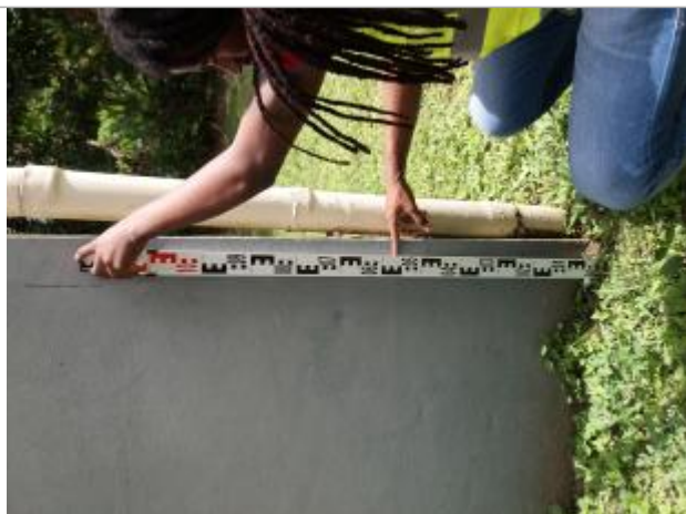
Dépôts de matières solides
