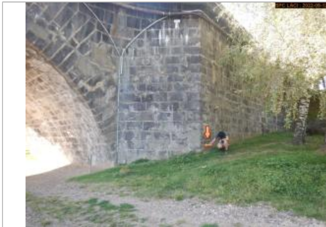
Vue du site éloignée
