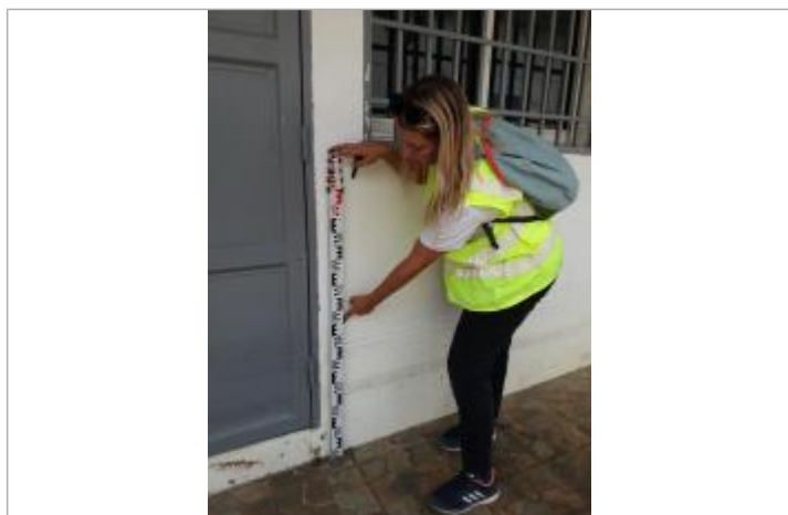
Niveau mesuré depuis la dalle carrelée
