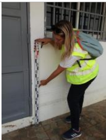
Niveau mesuré depuis la dalle carrelée
