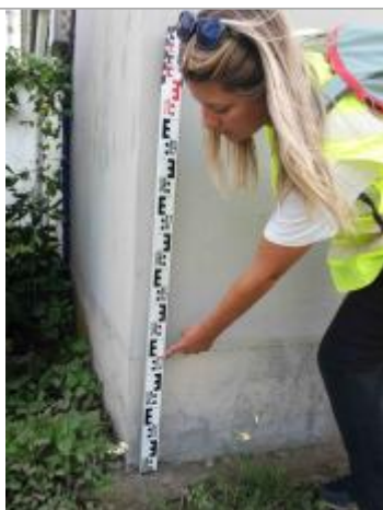
Niveau mesuré depuis le rebord béton
