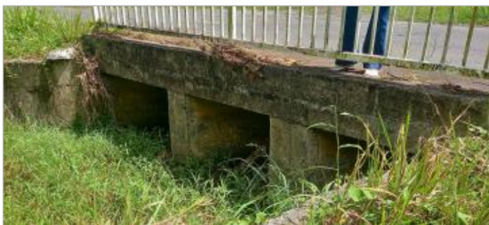
Vue détaillée du repère
