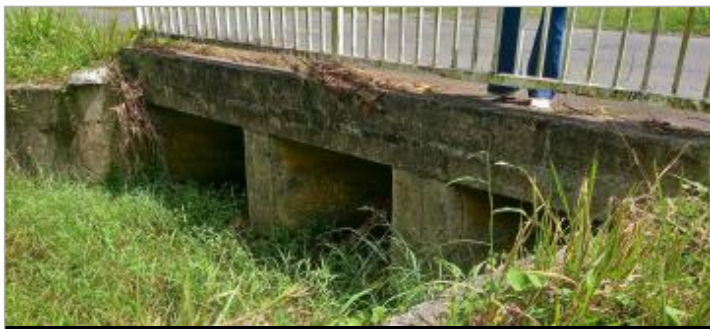
Vue détaillée du repère
