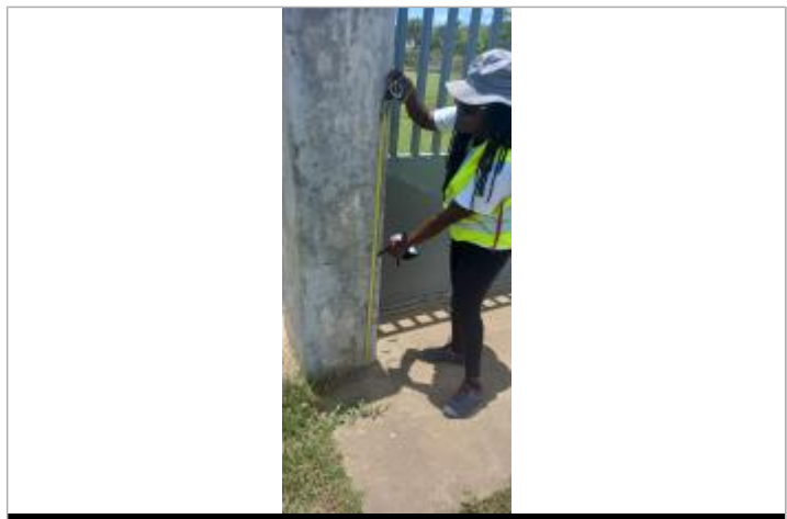
Vue détaillée du repère
