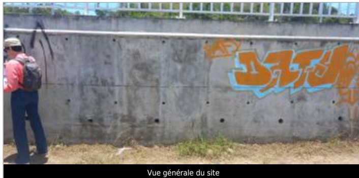
Vue générale du site
