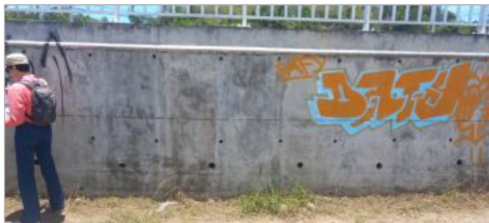
Dépôts matières solides
