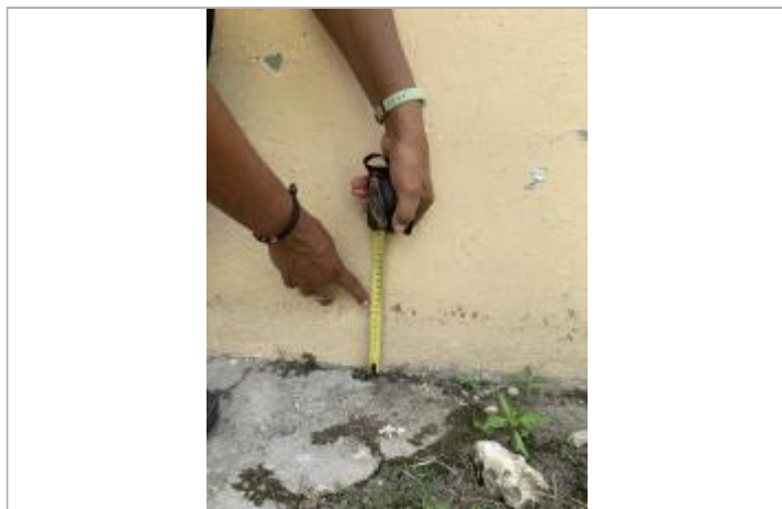
Dépôt de matières solides
