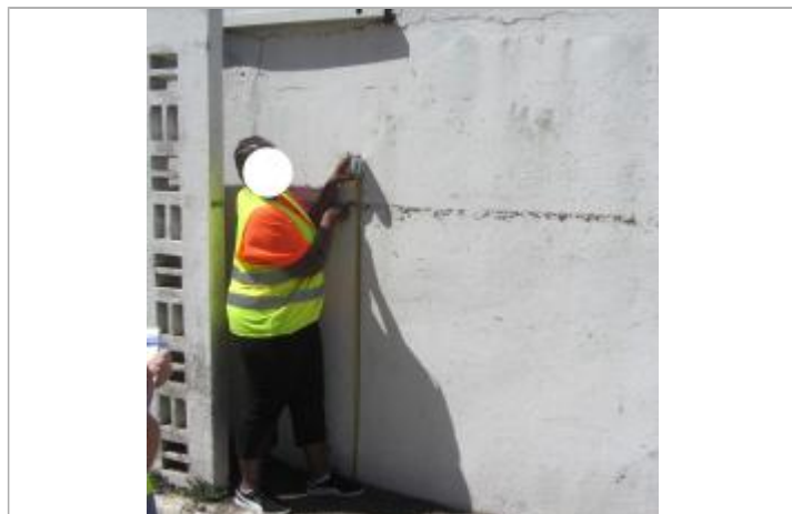
Dépôt de matières solides
