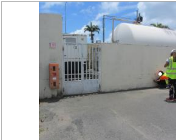
Mur de clôture
