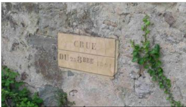
Repère sur parement aval gauche
