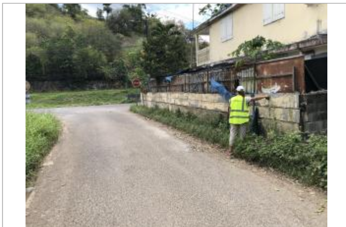
Mur de clôture
