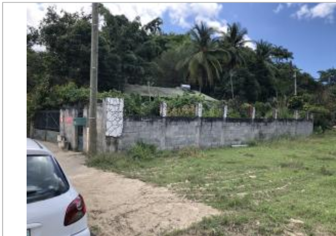
Dépôts sur le poteau électrique proche d'une habitation
