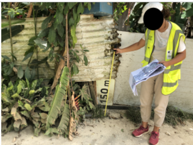
Dépôts de matières solides
