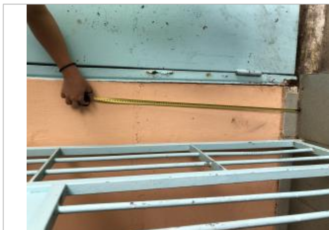
Dépôts de matières solides
