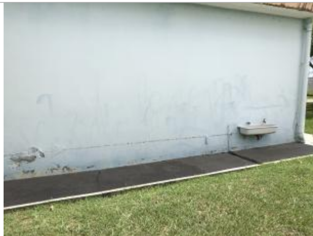
Façade extérieure du bâtiment dans la cour
