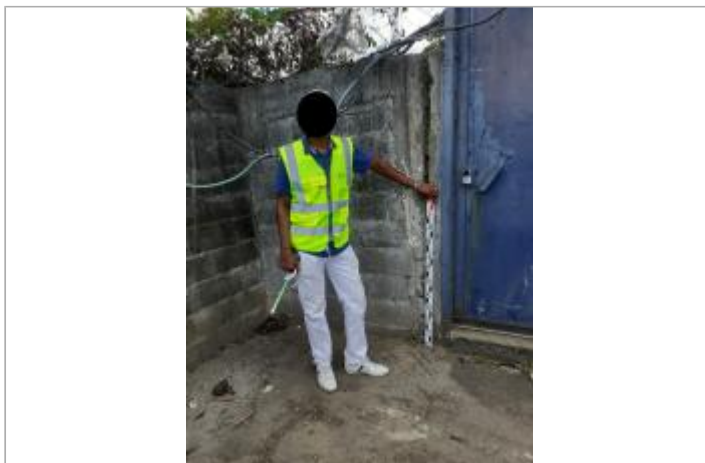
Mur en parpaing à proximité de la porte
