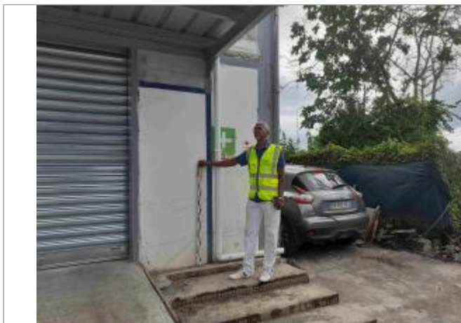
Canal usine de produits chimiques / Parking
