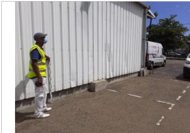
Mur blanc façade en tôle sur parking
