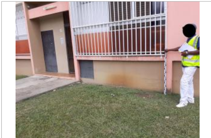
Mur façade extérieure
