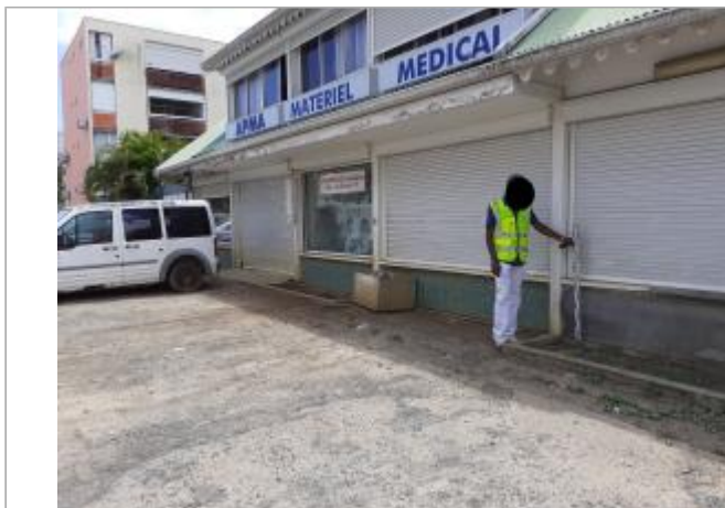
Façade bâtiment médical
